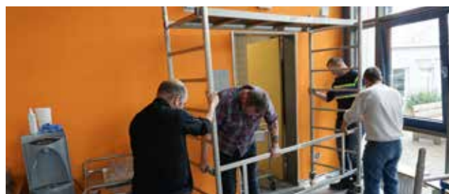
Aufbau des Gerüsts
