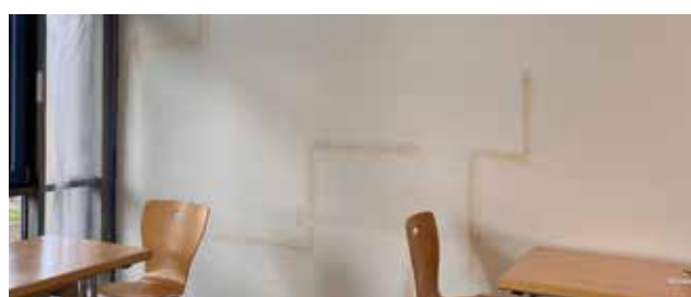
Ausbesserung der Risse (Spachtelarbeiten)
