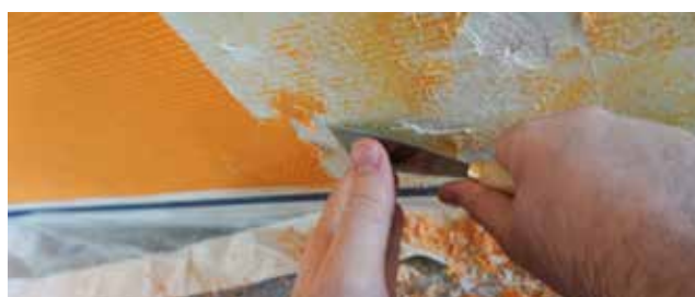
Ausbesserung der Wand
